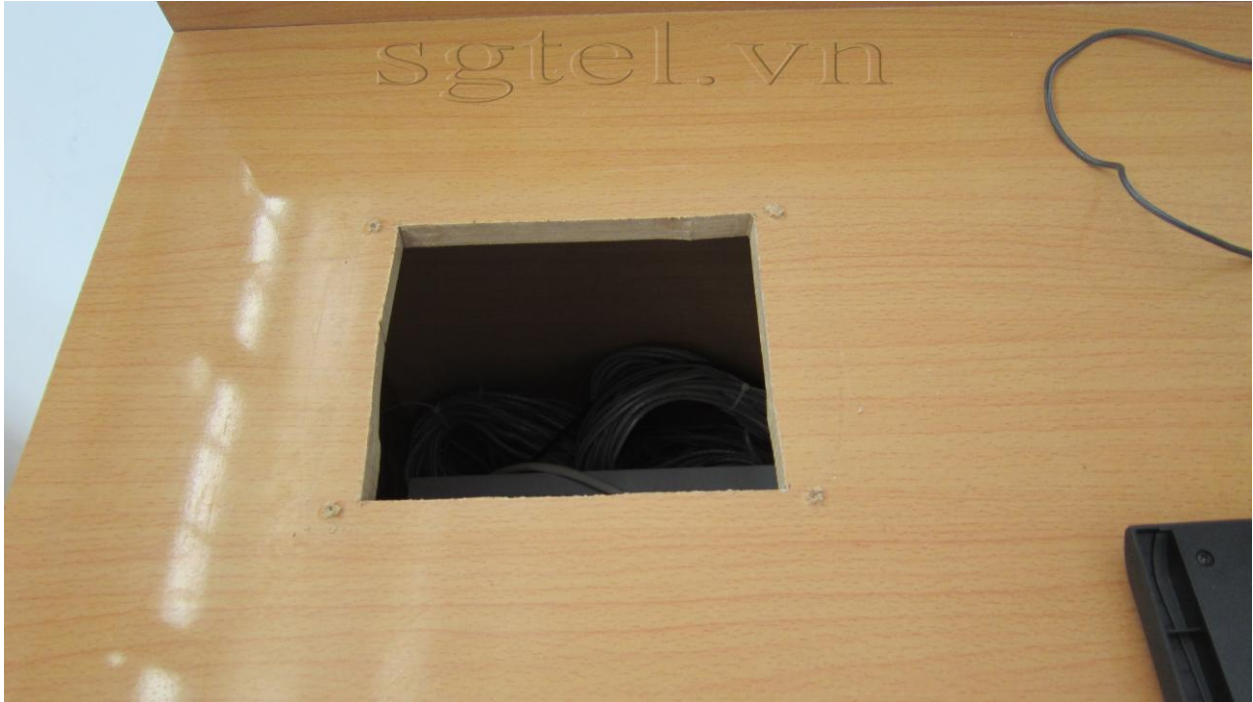
Hình minh họa: Vị trí khoét lỗ để lắp cassette
