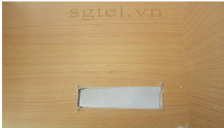
Hình minh họa: Vị trí khoét lỗ để lắp Student Booth Amplifier & Analyser
